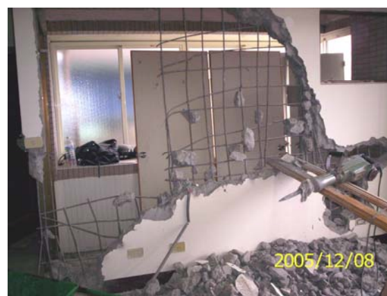
▲ 室內裝修分間牆變更涉結構安全者，應經開業建築師簽證負責。
