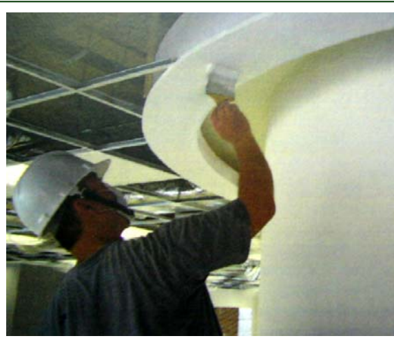
▲一般居室空間以木板裝修部分，得採用經檢驗符合規定的防火塗料刷塗改善。
