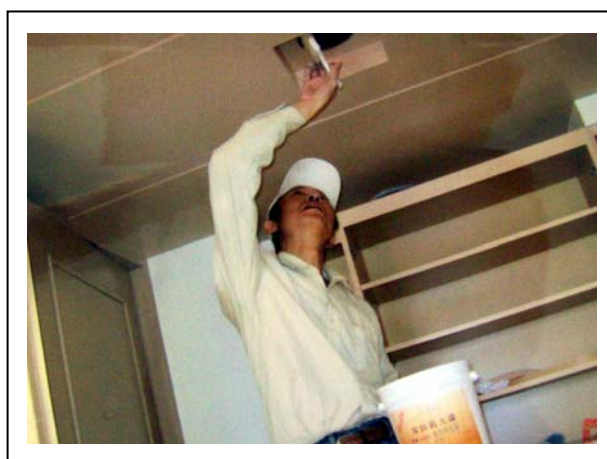
▲ 防火塗料之施工過程必須拍照存證，現場實際施工人員並應入鏡。
