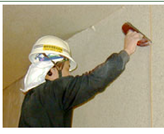
▲防火壁紙（布）之耐燃標示，僅顯示試驗基材以接著劑黏貼壁紙（布）後的耐燃等級變化，不能直接比照建築技術規則所稱的耐火板或耐燃材料。
