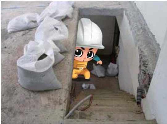
室內上、下樓層間的樓板局部拆除及增設樓梯應檢討結構安全及辦理申請
