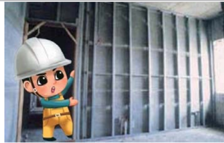
輕質的材料裝修—輕鋼架天花板及輕質隔間牆
