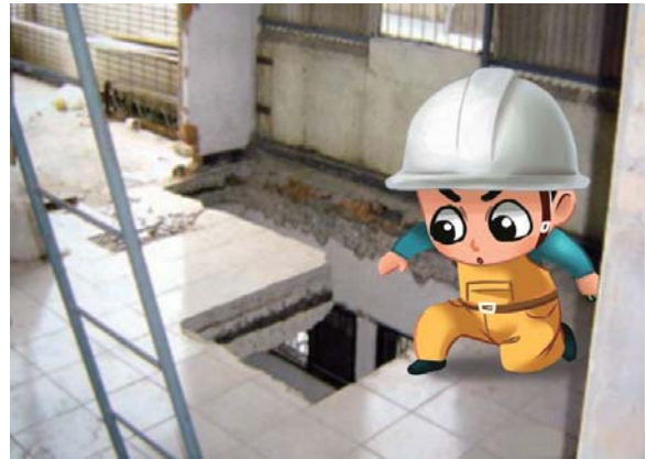
拆除樓地板涉及主要構造之變更
