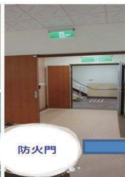
如將原有防火門，擅自更改為玻璃門，形同破壞防火區劃
