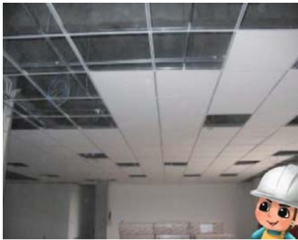
輕質的材料裝修—輕鋼架天花板及輕質隔間牆
