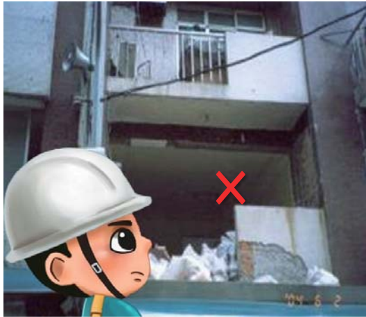
擅自拆除外牆(陽台外推)，已涉及違章建築行為
