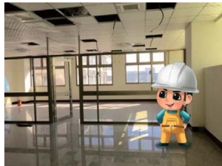
輕質的材料裝修—輕鋼架天花板及輕質隔間牆
