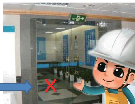
如將原有防火門，擅自更改為玻璃門，形同破壞防火區劃
