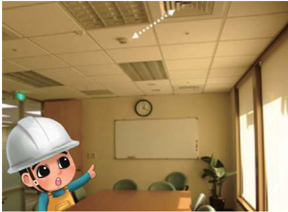
火警探測器之裝設， 距離空調出風口至少應達 1.5m 以上
