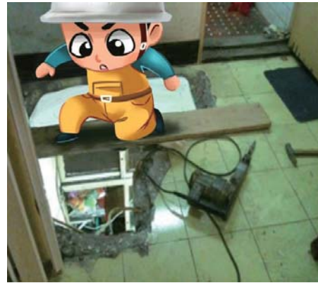
室內上、下樓層間的樓板局部拆除及增設樓梯應檢討結構安全及辦理申請
